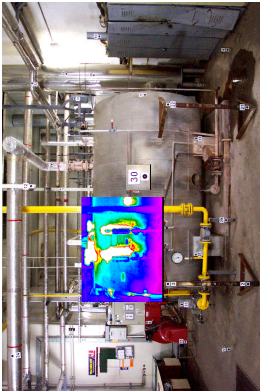
Rys. 1. Obiekt testowy – zdjęcia cyfrowe wykonane aparatem Kodak DC4800 i kamerą termalną AGEMA 880 w fazie opracowania.
